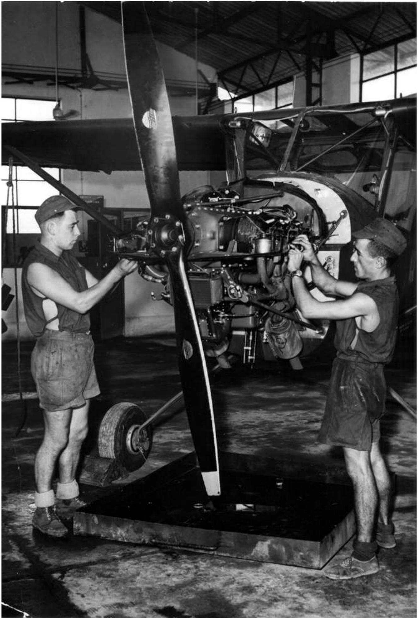
*En, 1956, au 22° GAOA, les mécaniciens au travail sur le moteur Continental d'un L-19A (photo Gérard Demange).*
